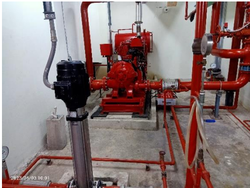
ปั๊มสูบน้ำดับเพลิงและ jockey pump
