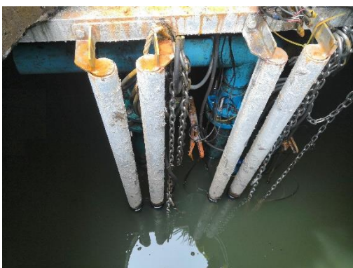
ปั๊มสูบน้ำเสียที่ผ่านการบำบัดแล้วมารดน้ำต้นไม้
