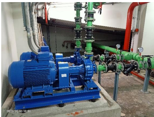
ปั๊มสูบน้ำประปาขึ้นไปยังถังเก็บน้ำชั้นดาดฟ้า
